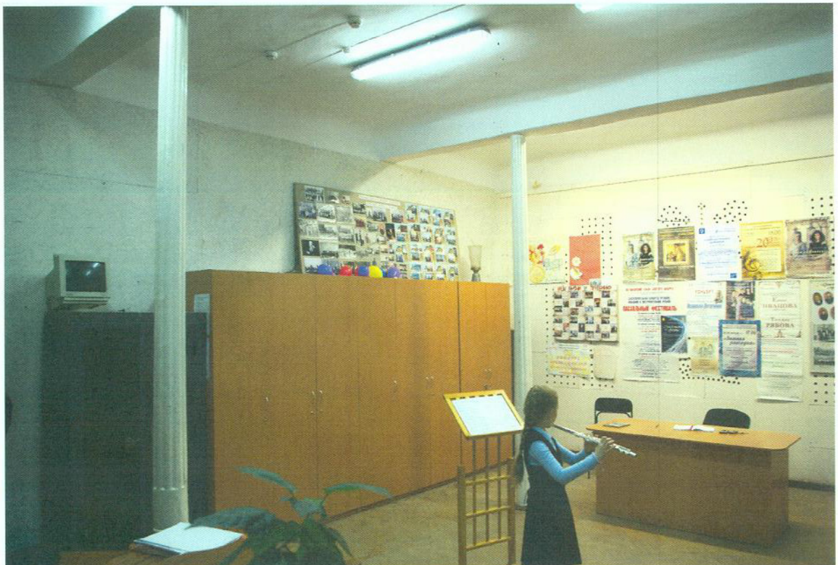
Фото 3. Интерьер. Наличие на первом этаже в восточной секции здания чугунных литых колонн, поддерживающих балки перекрытия. Автор съёмки – Марьин Д.В., дата съёмки – 31.10.2014 Кировская область, г. Киров, ул. Спасская, дом 15 литер А1 «Магазин Сунцовых».
